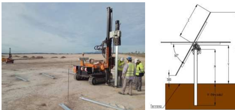
Figura Fotografía y esquema del hincado.
